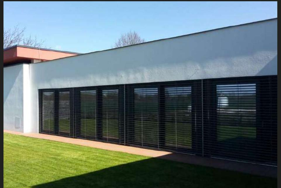
**La lame Z 90** est dotée d'un joint en caoutchouc éliminant le bruit extérieur lorsque les lames sont en position fermée.
